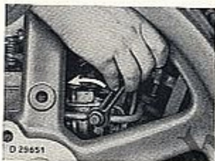
Bild 10. Entlüften der Schmierölanlage
