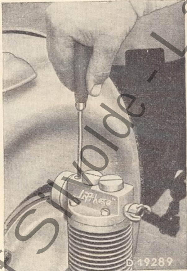
Fig. 87: Borgschroef van het filter
